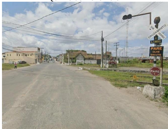
Figura 27 - Interseção com linha férrea na Rua Quinze de Novembro
