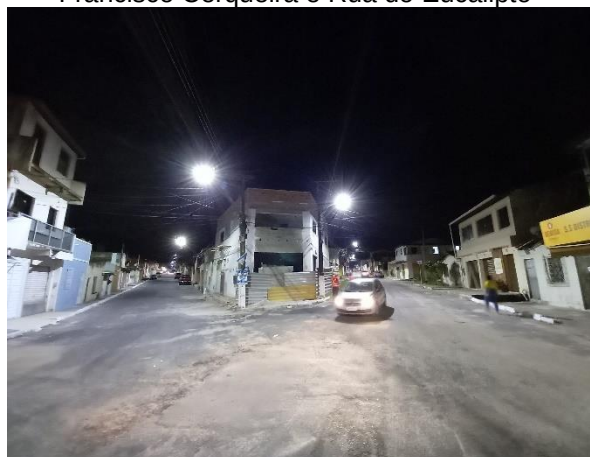
Figura 30 - Luminárias em LED nas Ruas Francisco Cerqueira e Rua do Eucalipto
