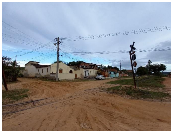
Figura 26 - Interseção com via férrea na Rua Macário Mendes
